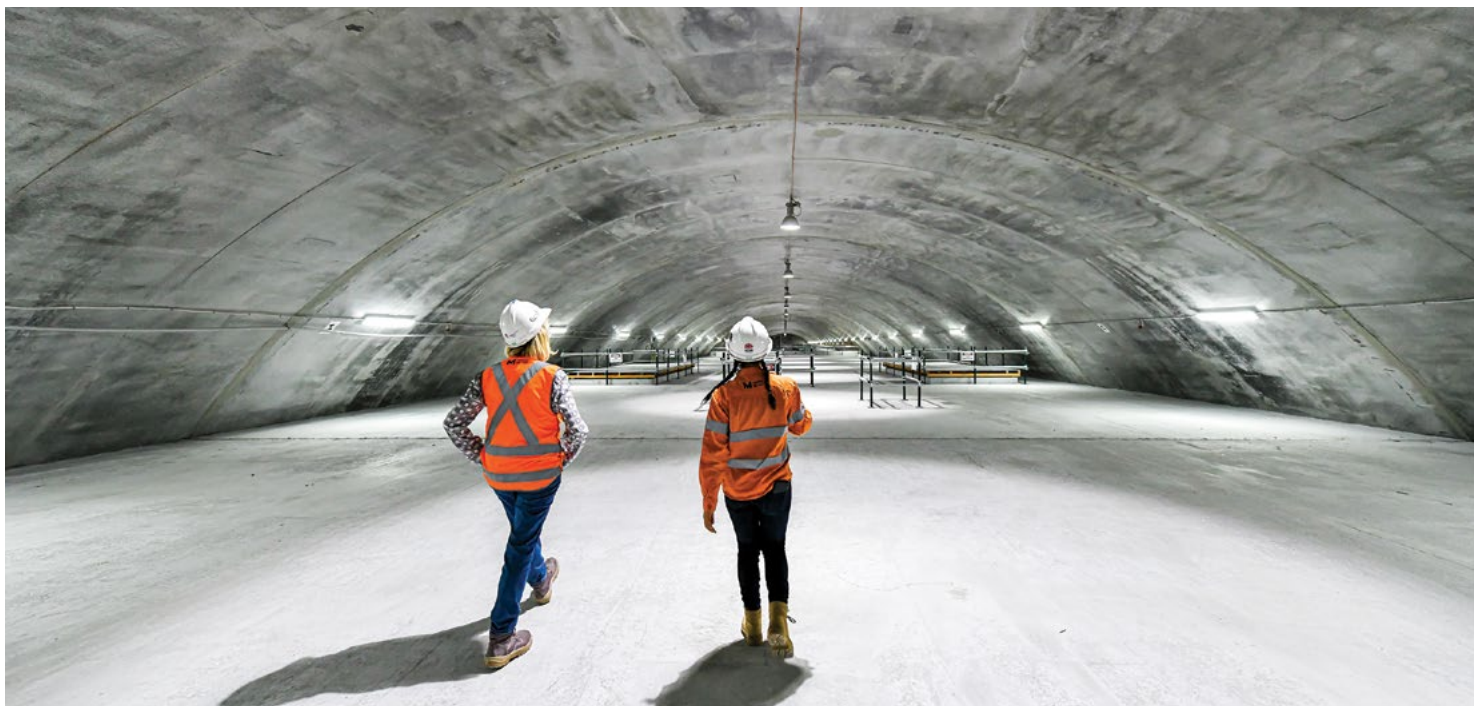
Hang động trong dự án Sydney Metro City & Southwest project.
