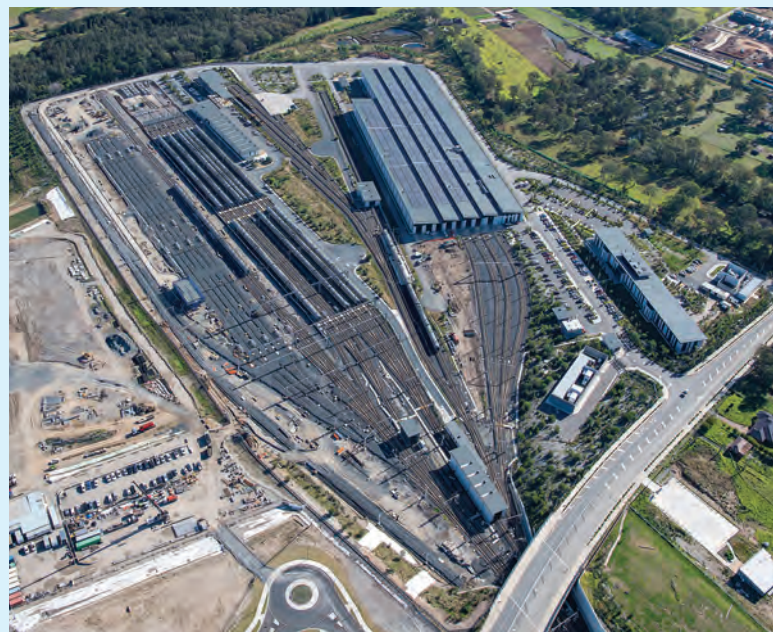
Metro North West Line पर Rouse Hill पर स्थित Sydney Metro Trains Facility
