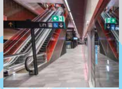
Una stazione della Sydney Metro.
