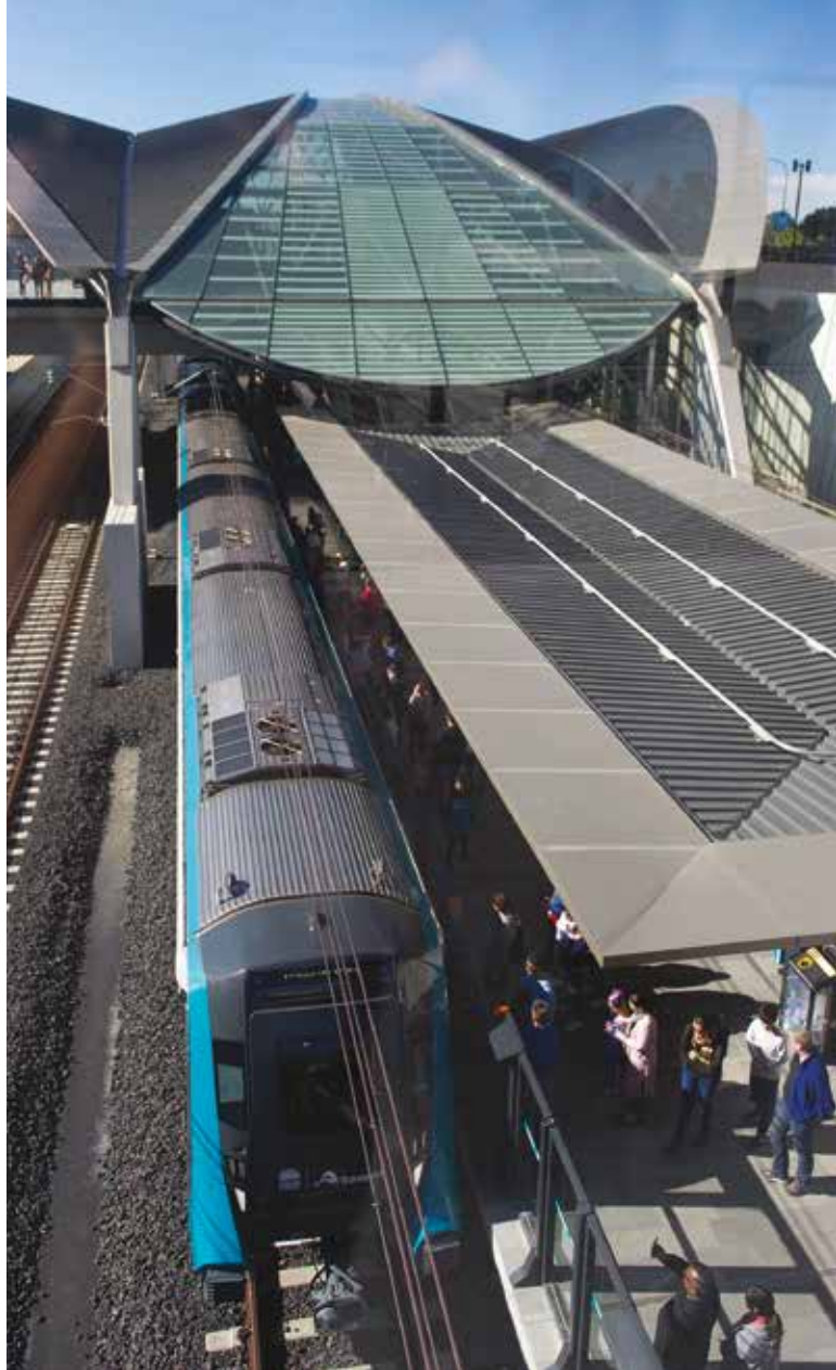
Metro North West Line, giornata di apertura della stazione di Tallawong, 26 Maggio 2019.
