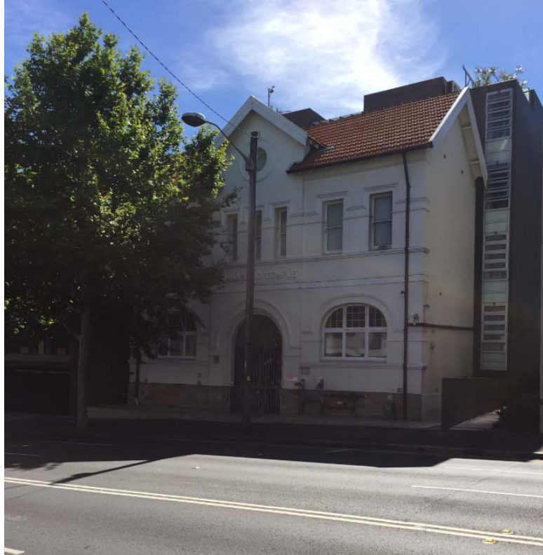
Plate 9 : Co Masonic Temple (RPS, 2016)
